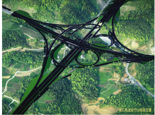
그림 6. 중국 메이탄-시취안 고속도로 Fig. 6. Meitan-Siquian highway in China
