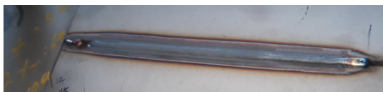
(a) 용접부위 사진 (a) Welded
