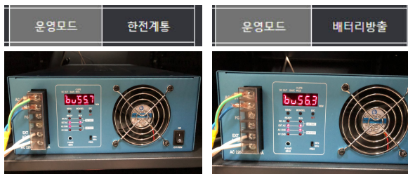
그림 10. 분석 및 예측 기반 ESS 능동제어 Fig. 10. Active control of ESS based on analysis and forecast
