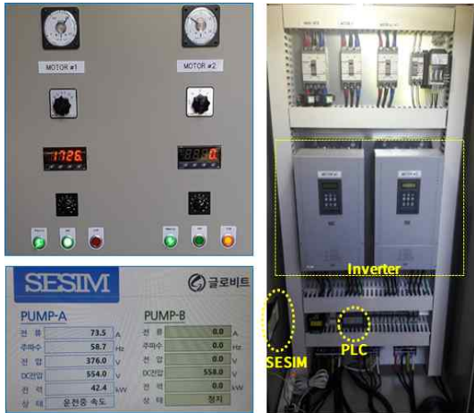
그림 8. 인버터 내부와 SESIM Fig. 8. Inside the inverter and SESIM
